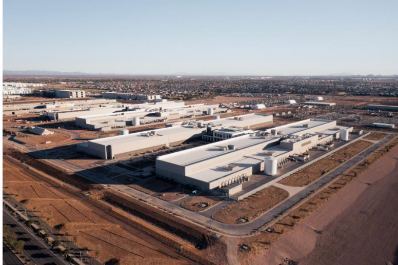
Figuur 3: Datacenter van Meta geopend in Arizona, VS, in januari 2025.
